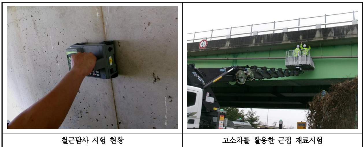
【사진 2.4.2】 철근탐사 시험
