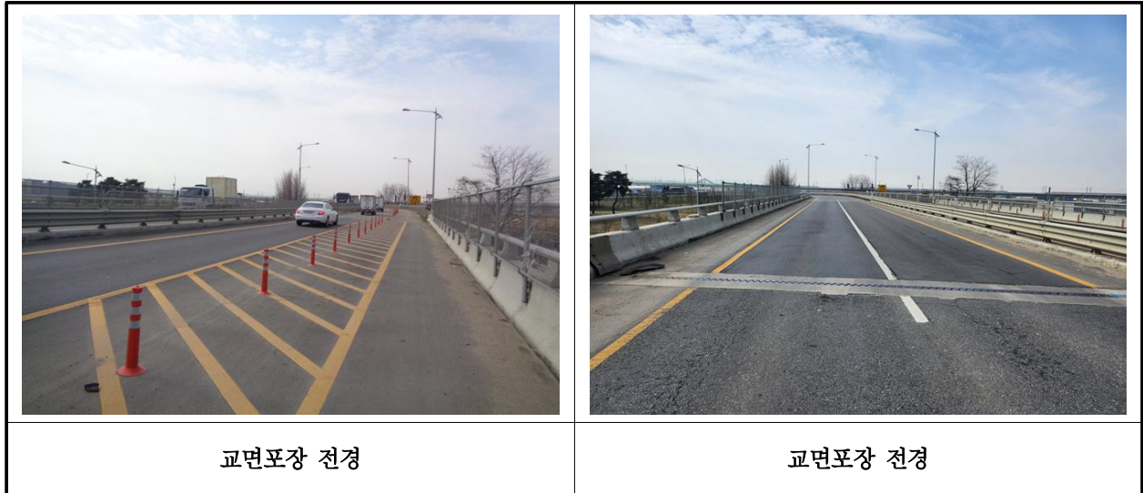
【사진 2.3.17】 교면포장 전경
