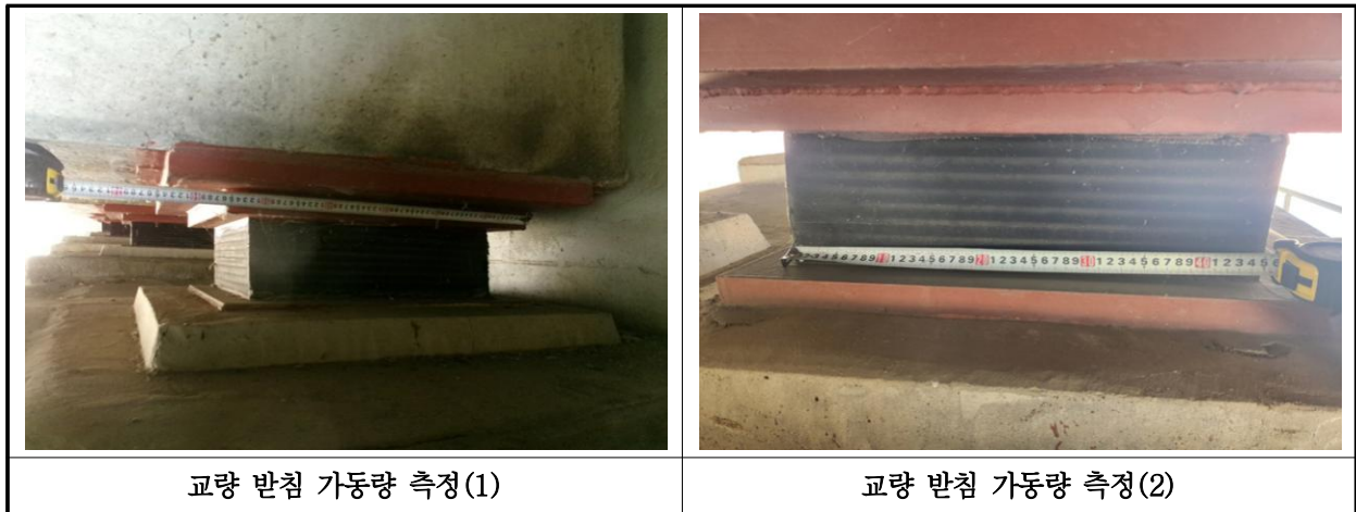
【사진 2.3.13】교량받침 이동량 측정
